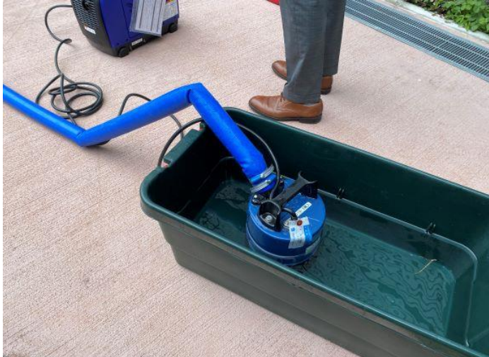
【水害訓練】発電機で排水ポンプを運転
